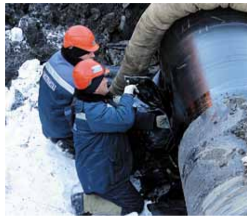
Работу проводят бригады УАВРа
