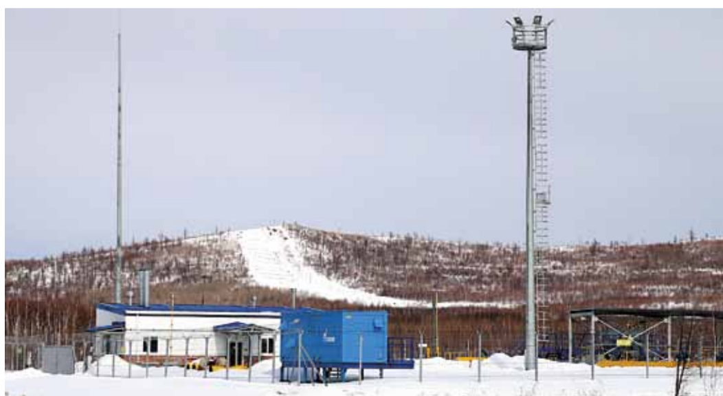
По живописным сопкам пролегает трасса газопровода в Хабаровском крае
